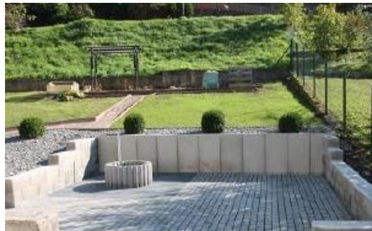
Auw a. d. Kyll, Errichtung eines Grillplatzes am Dorfgemeinschaftshaus
