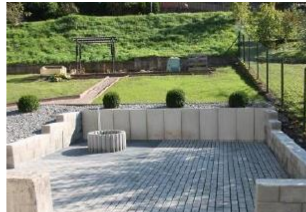
Auw a. d. Kyll, Errichtung eines Grillplatzes am Dorfgemeinschaftshaus
